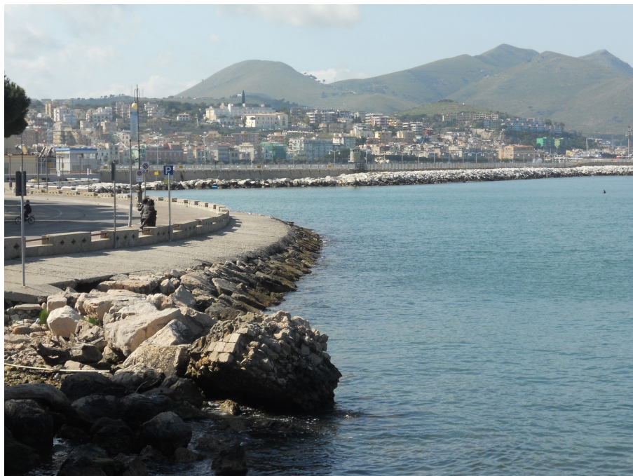
Fig. 58 Tratto finale del banchinamento presente sul lungomare di Gaeta e scogliera a protezione del muro di recinzione della base NATO
