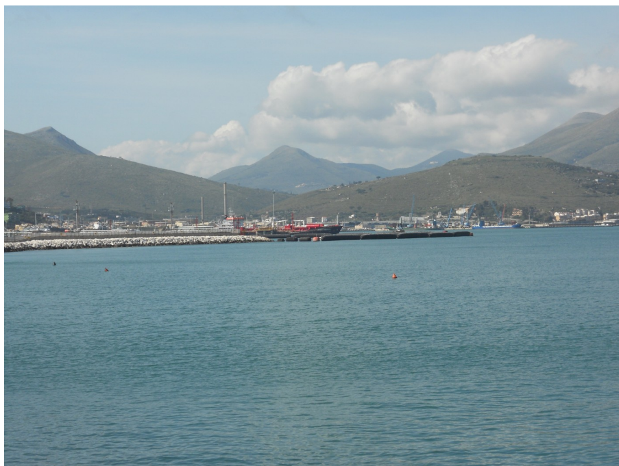
Fig. 59 Tratto finale della scogliera a protezione del muro di recinzione della base NATO. In lontananza gonfiabili usati per lavori portuali in corso
